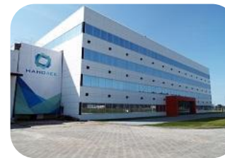
Нанолек Строительство завода в Кировской области
