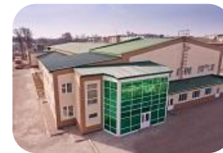
Фармасинтез Строительство завода в Иркутской области
