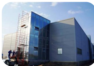
БИОКАД Строительство производственного комплекса в Нойдорф, п. Стрельна, г. Санкт-Петербург
